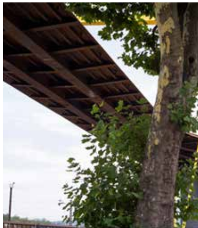
Vue du pont du dessous, montrant sa structure en acier et les courbes du chemin.
